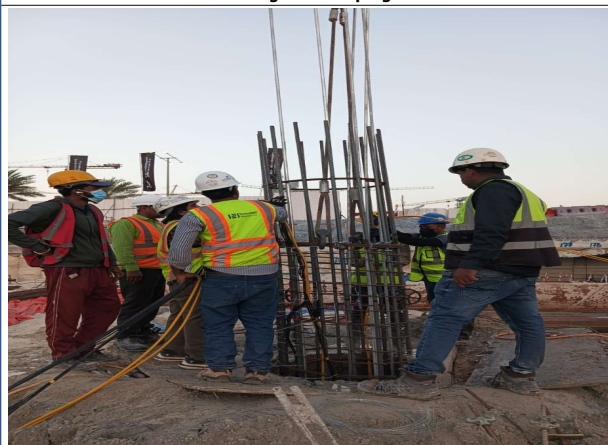
PTP Piles Placement
